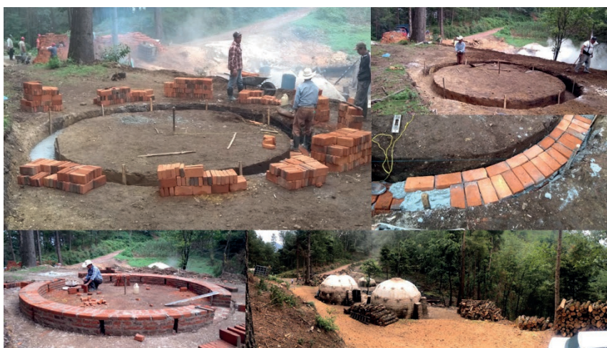
Figura 12. Construcción de un horno media naranja argentino en el ejido Tenantitlán, Huayacotla, Veracruz.
