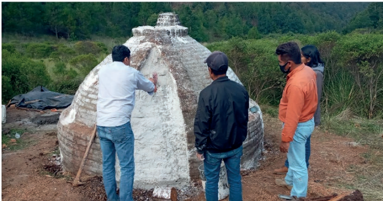
Figura 16. Sellado del horno para su rápido enfriamiento. Fuente: INIFAP, 2020.
